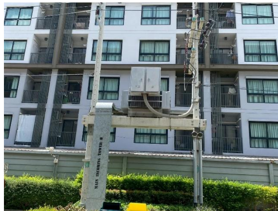
หม้อแปลงไฟอาคาร B ภาพที่ 2-2 ระบบไฟฟ้า
