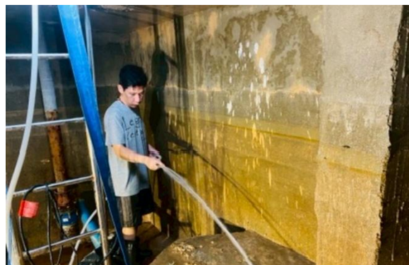
การทำความสะอาดถังเก็บน้ำใช้ ภาพที่ 2-6 (ต่อ) ระบบน้ำใช้ของโครงการ
