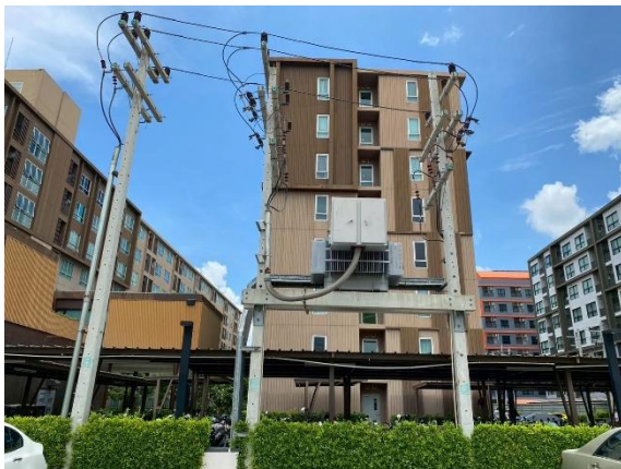
หม้อแปลงไฟอาคาร A
