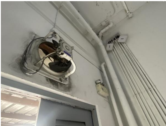
พัดลมระบายอากาศในห้องเครื่องสูบน้ำ
