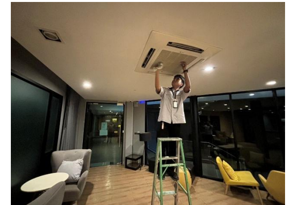
ภาพที่ 2-23 การทำความสะอาดเครื่องปรับอากาศ
